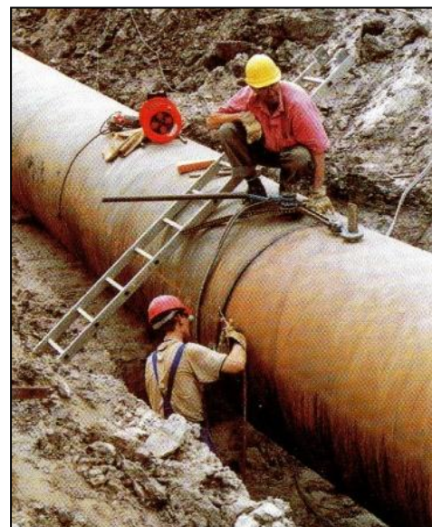
Bild 7 Verlegung der Rohrleitung DN 1400 [12]
