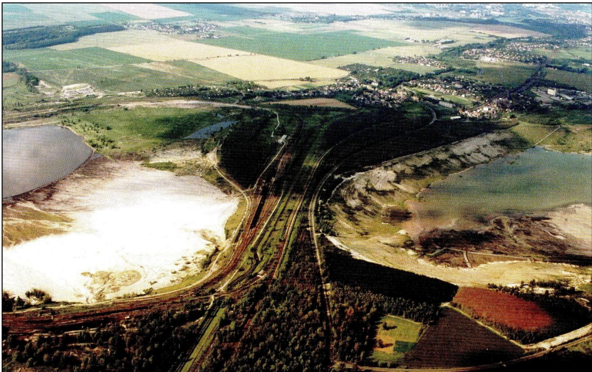
Bild 2 Kippendamm mit Fahrstraße, Eisenbahngleisen und neuem Geiselbett zwischen Braunsbedra (unten, nicht im Bild) und Frankleben (oben) während der Flutung (rechts TRL Großkayna, heute Runstedter See, links TRL Braunsbedra, heute Teil des Geiseltalsees, Aufnahme: 2005) [7a]
