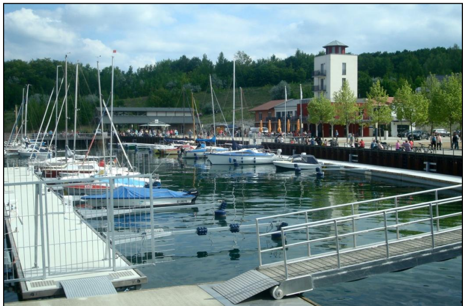
b_kleines Bild darunter: Entstehung der Hafenkante mit der Aufschüt- tung davor, 22.9.2007,
