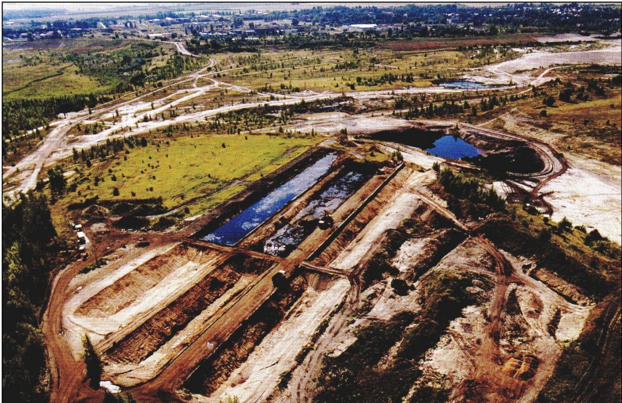
Bilder 5a+b Die sechs betonierten Säureharzbecken auf der Innenkippe ‚Leonhardt‘ während der Sanierung [7f,11b]
