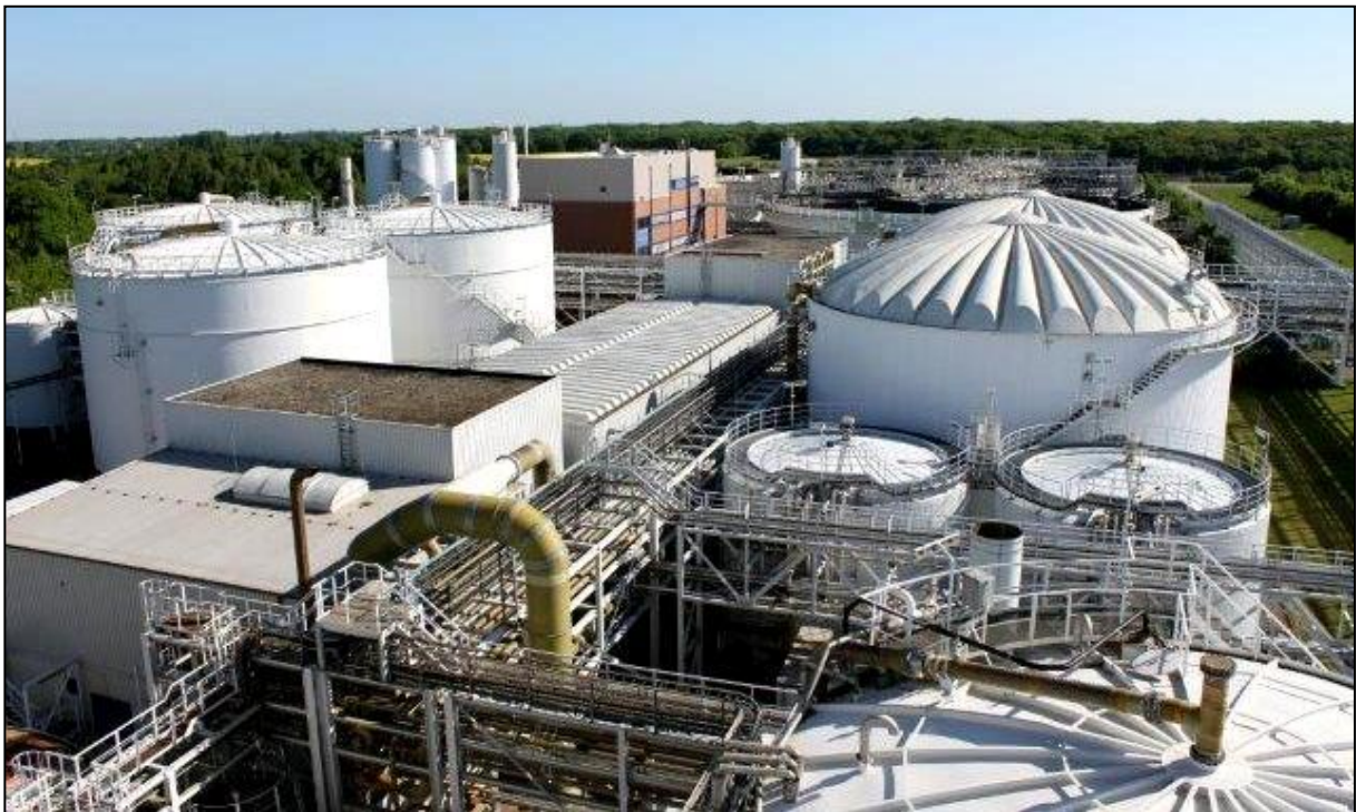
Bild 1 Das 1994 in Betrieb genommene Klärwerk
