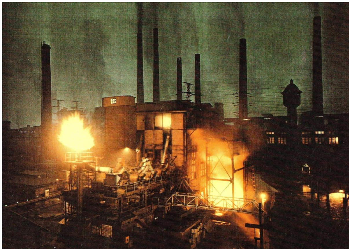
Bild 7 Nachtaufnahme des Phosphorbetriebes im EKB um 1960 (links: das Abfackeln von CO, rechts: der Abstich der Silikatschlacke) [17]
