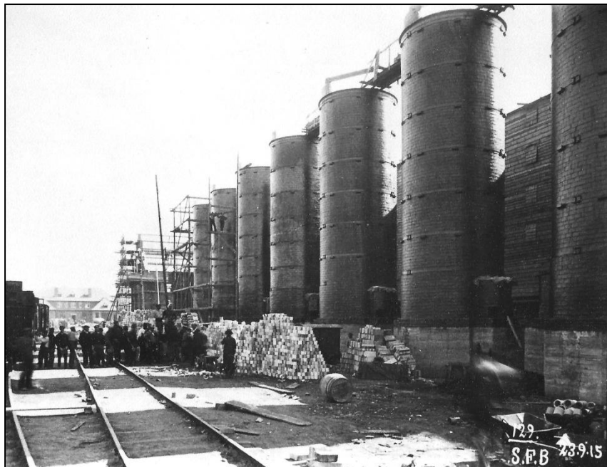
Bild 5 Bau der Säurefabrik Bitterfeld, Blick auf die Steuler-Absorptionstürme (Aufnahme: 23.9.1915)
