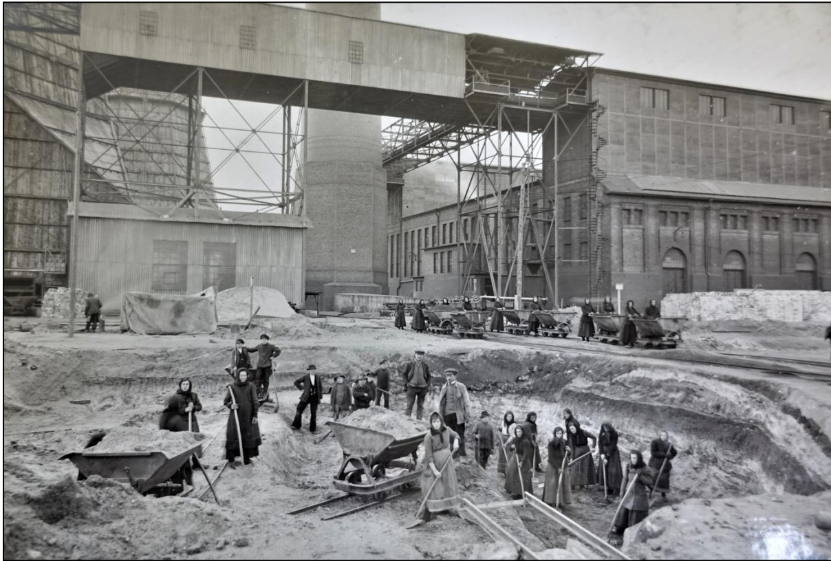
Bild 11 Ausschachtungen für die Fundamente des Kraftwerkes Süd (1915)
