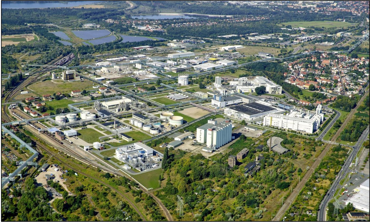
Bild 1 Luftbild vom Areal C des Chemieparks Bitterfeld-Wolfen (im Vordergrund links die Anlagen der Nobian GmbH, mittig mit schwarzem Dach das zentrale Verwaltungs- und Mehrzweckgebäude)
