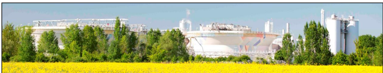
Bilder 4a+b Das Gemeinschaftsklärwerk (GKW) , a_Bild oben: Blick auf das GKW, vorn, und das Areal B des Chemiaparks, hinten, Luftbild, b_Bild unten: die BIOHOCH®-Reaktoren )
