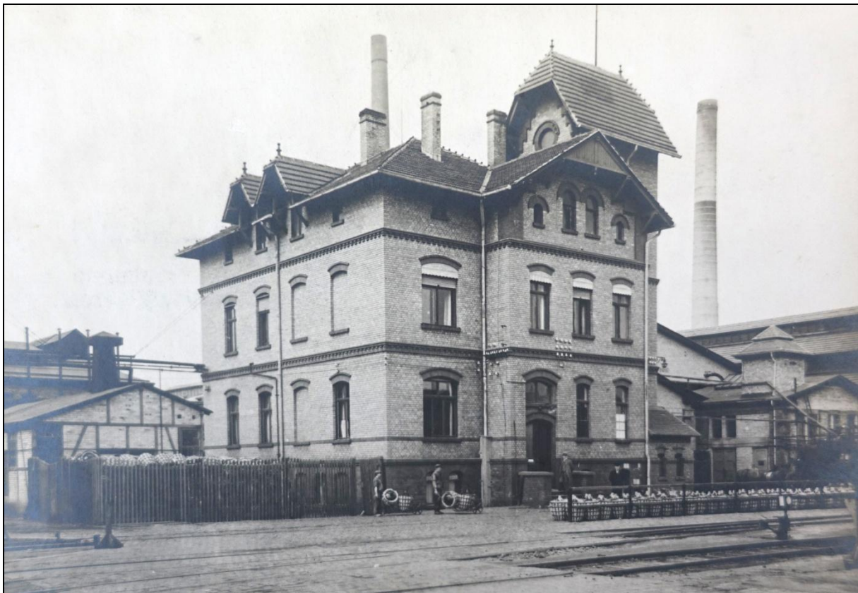
Bild 2 Wohn- und Arbeitsstätte von Walther RATHENAU im Werk Bitterfeld Nord von 1893 bis 1907
