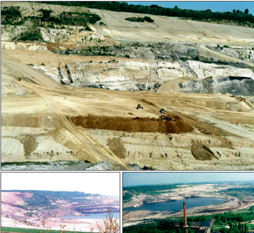
Bilder 7a-c Einsatz von Universalbagger, LKWs und Planiererraupen bei den Sanierungsarbeiten im Westfeld des ehemaligen Tagbaus Mücheln am FüÙe der Halde Klobikau (kleine Bilder: Blick von Südwesten auf Westfeld und Halde Klobikau, um 1993)
