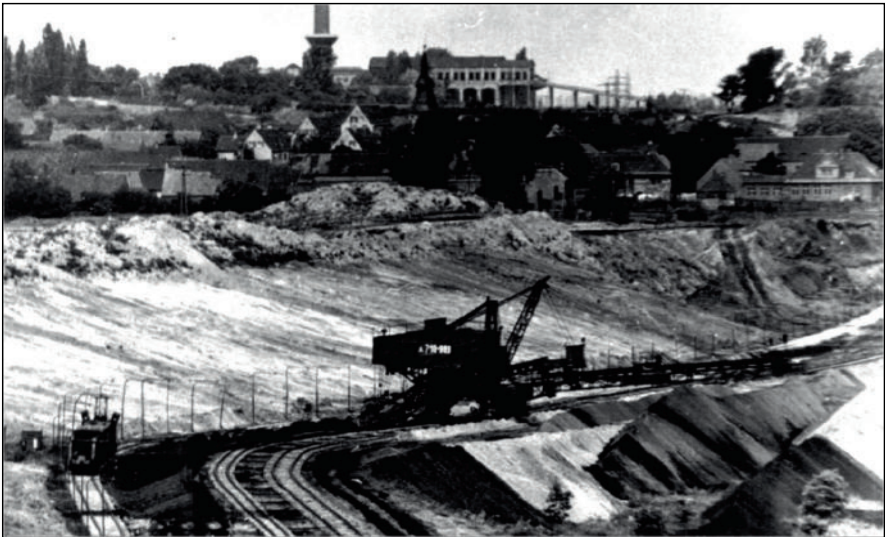
Bild 3 Absetzer 989 A 710 (Baujahr 1925), im Jahr 1980 vor der Ortslage Stöbnitz (Außerbetriebnahme 1993)
