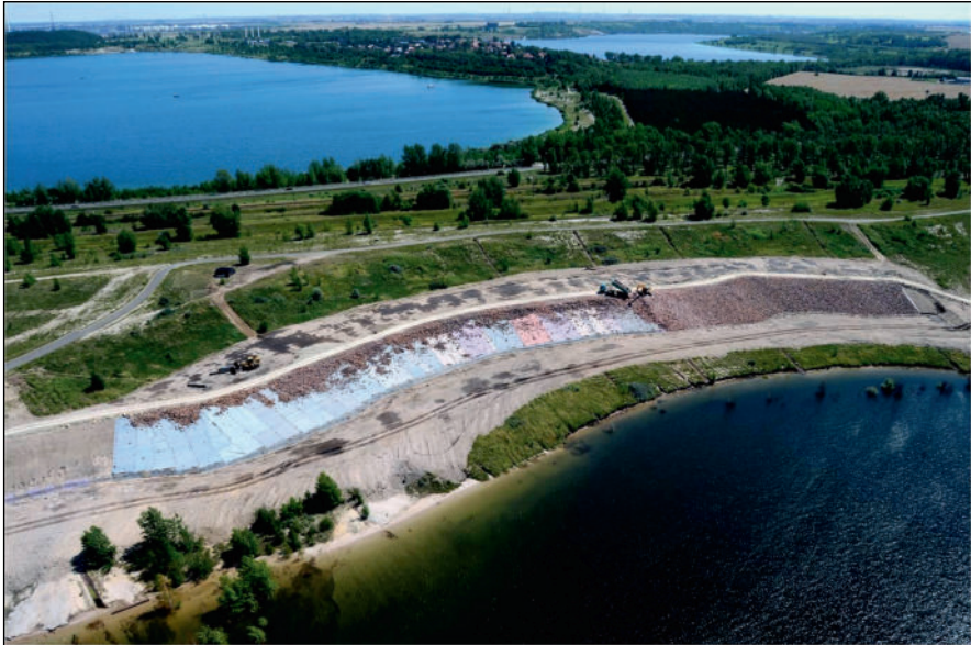
Bild 9 Böschungsstabilisierung mit Wasserbausteinen (Blick von Nordosten auf die Südostecke des Geiseltalsees, im Hintergrund links der Runstedter See, rechts der Großkaynaer See [Südfeldsee], 2008)
