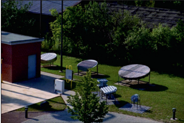
Bild 5 Blick auf die Kolonnen- einbauten bzw. Kolonnen- böden neben dem Messwartenhäuschen der Butadien- Destillationskolonne (Aufnahme: 2004)
