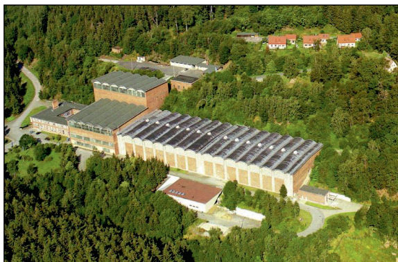
Bild 8 Blick auf die Trinkwasseraufbereitungsanlage Wienrode (2004) [14d]
