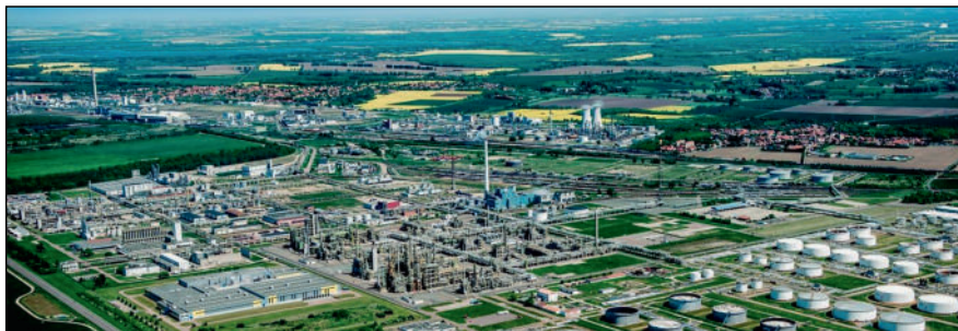
Bild 1 Blick von Südwesten auf den Chemiestandort Leuna (vorn die TotalEnergies Raffinerie, im Hintergrund links die Stadt Leuna, daneben am linken Bildrand das Kraftwerk GuD1 der InfraLeuna mit seinem weithin sichtbaren hohen Schornstein, mittig am rechten Bildrand die Ortslage Spergau, vgl. Lageplan S.97)
