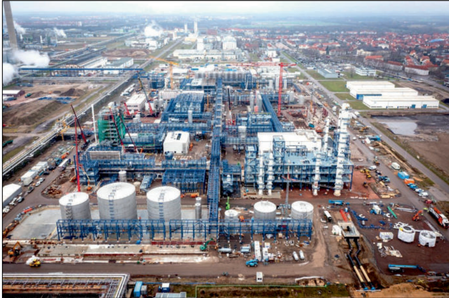
Bild 1 Blick von Süden auf einen Teil des Chemiestandortes Leuna mit der im Aufbau begriffenen Bioraffinerie der UPM Biochemicals GmbH (an der Stelle, wo früher die alte Leuna-Raffinerie stand, vom linken Bildrand unten in die Mitte oben verläuft die Werksstraße 7, oben rechts die Ortslage Leuna, Stand: Anfang 2023, vgl. Bild 3 auf Seite 67)
