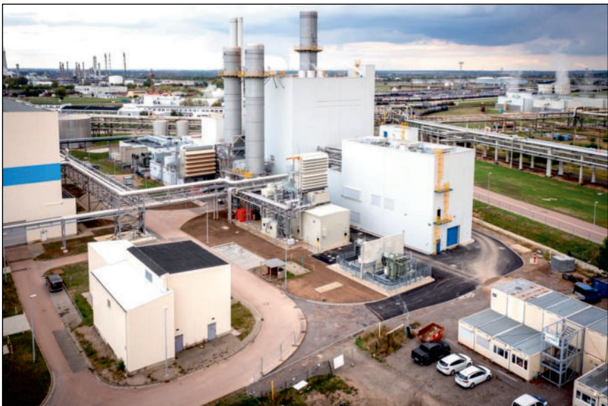
Bild 2 Das Gas- und Dampfturbinenkraftwerk (GuD) der InfraLeuna GmbH
