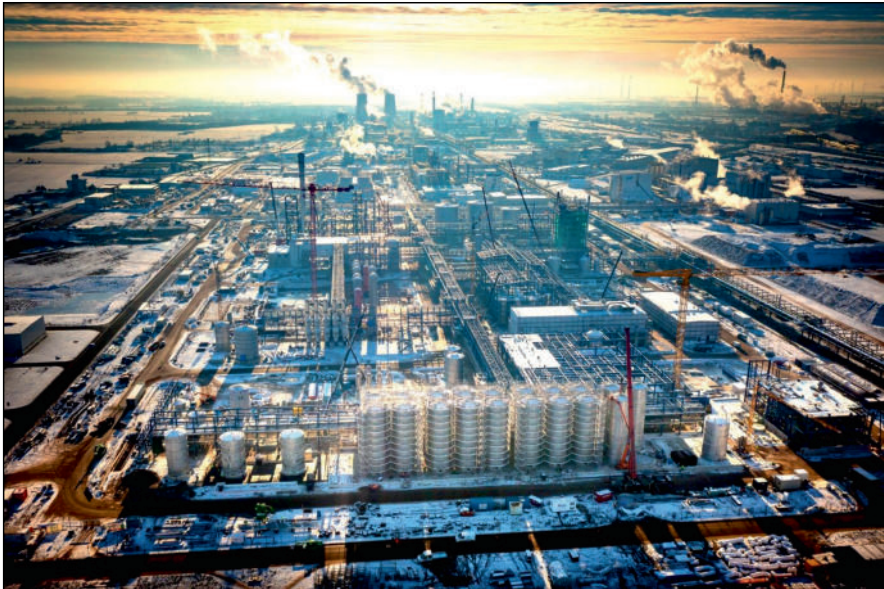
Bild 3 Blick von Norden auf die Baustelle der UPM-Bioraffinerie am Standort Leuna (rechts davon die Anlagen der Leuna Harze GmbH, am oberen Bildrand die Ortslage Spergau, rechts oben der Standort Leuna II, Aufnahme: 15.12.2022, s.a. MZ v. 7./8.1.2023)
