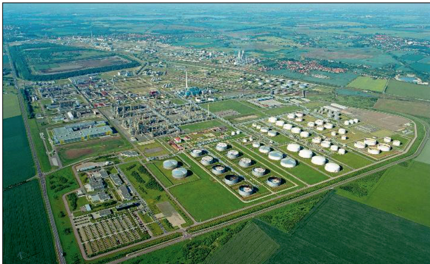
Bild 1 Die TotalEnergies Raffinerie in Leuna ist ein sehr wichtiger Bestandteil des größten zusammenhängenden Chemieparks in Deutschland mit ca. 12.000 direkten Arbeitsplätzen (Blick von Süden, im Vordergrund die Raffinerie, s.a. Lageplan S.97)
