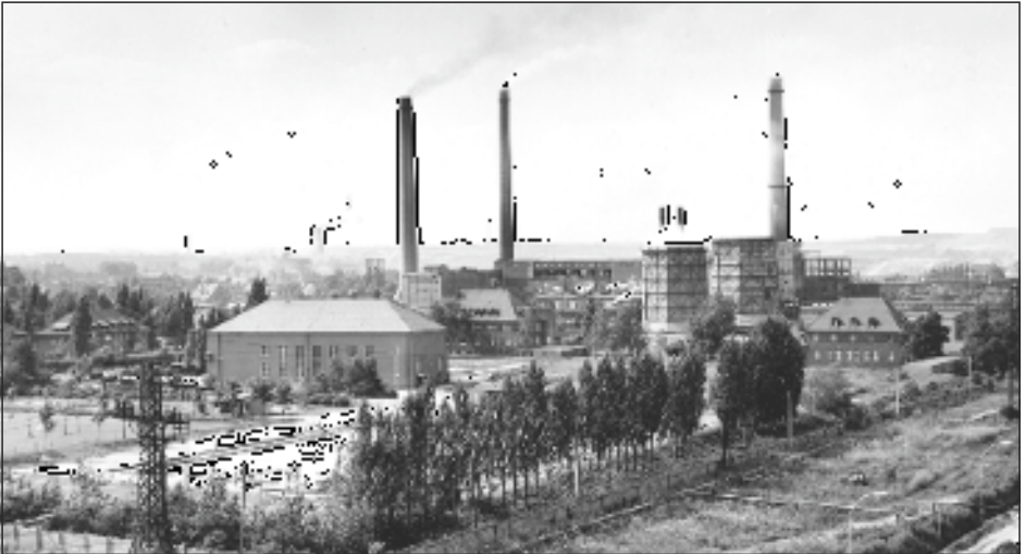
Bild 1 Das Mineralölwerk Lützkendorf 1955 (Blick aus südlicher Richtung auf das Kraftwerk-West, im Vordergrund Schwimmbad und Kulturhaus, rechts die „Alte Verwaltung“)
