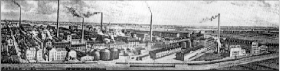
Bild 1 Blick auf die „Dessauer Werke für Zucker- und Chemische Industrie AG“ in den 1930er Jahren (Stahlstich) [1]
